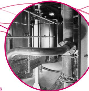
一家客户使用Mono的立式工业泵来帮助他们输送用于折叠包装 箱板喷涂的平滑乳胶涂料。
