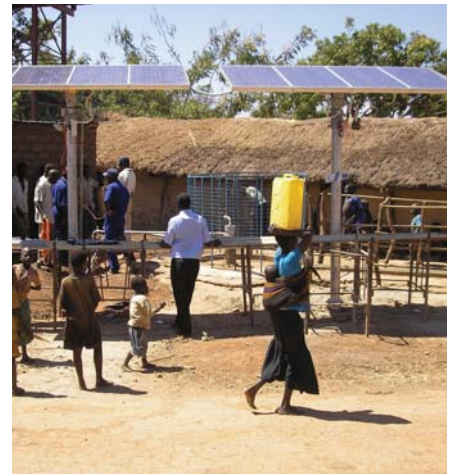
当地居民见到新的供水设施被安装十分高兴。
