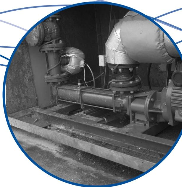
两台Mono生产的自动排污泵成套系统的安装给一家污水处理厂带来了平稳的运作。
